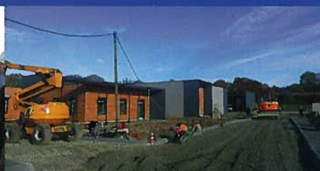
Le CTM une semaine avant la fin du chantier
